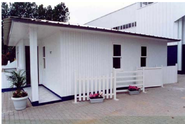
Fig. 14 - Casa fabricada em PVC ( http://www.institutodopvc.org/casapvc2htm )
